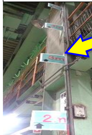
吊荷の高さ目安
